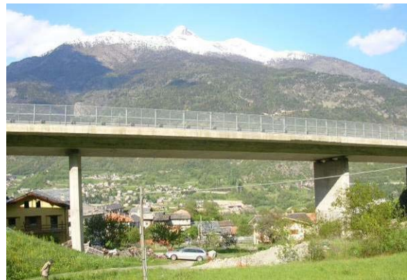
Viadotto La Forge (SS27, km 1+360)
