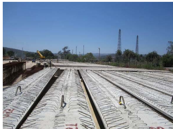
Linee di precompressione dei tegoli
