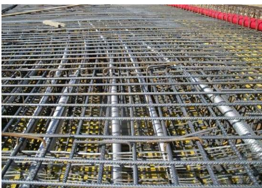
Particolare della gabbia di armatura e dei cavi di precompressione
