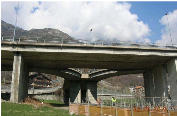
Viadotto San Valentino (SS26, km 75+510)
