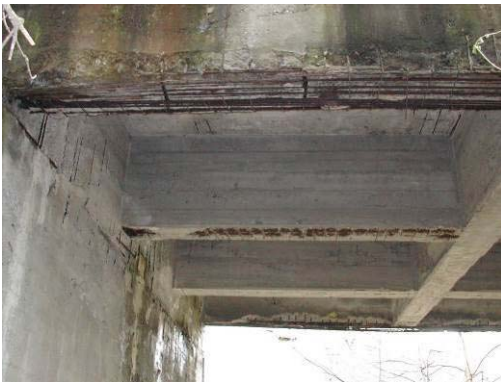
Stato di fatto – Vista intradosso impalcato
