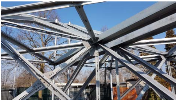
Particolare nodo struttura di controvento
