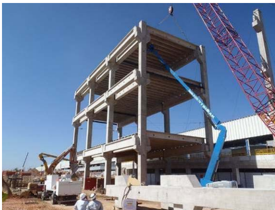
Porzione di edificio realizzata
