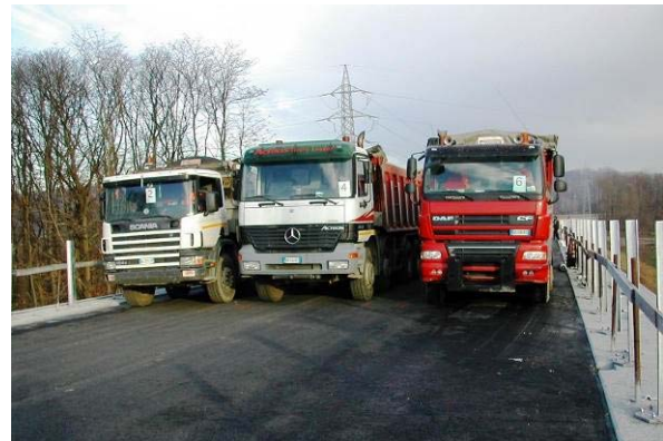
Collaudo della struttura
