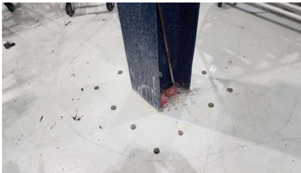
Rinforzo alla base delle colonne
