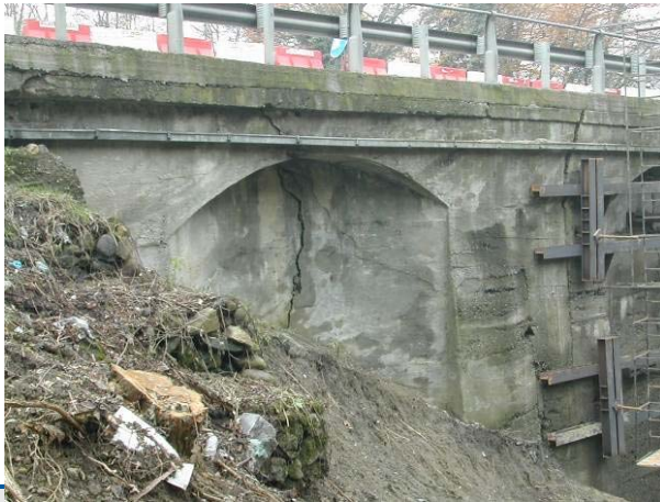
Esempio di danneggiamento spalla
