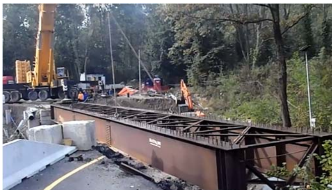
Varo di metà impalcato dalla posizione provvisoria a quella definitiva
