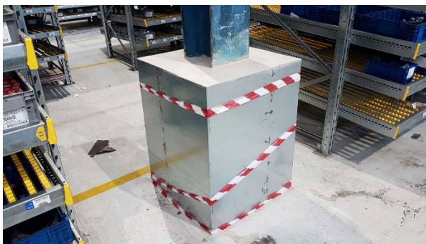
Rinforzo alla base delle colonne
