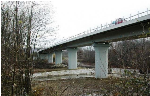
Vista laterale del viadotto
