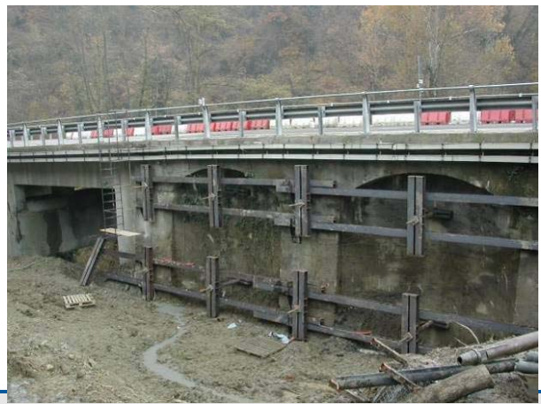
Intervento provvisorio di messa in sicurezza
