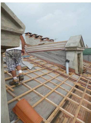
realizzazione di tetto ventilato con coibentazione in pannelli di fibra di legno
